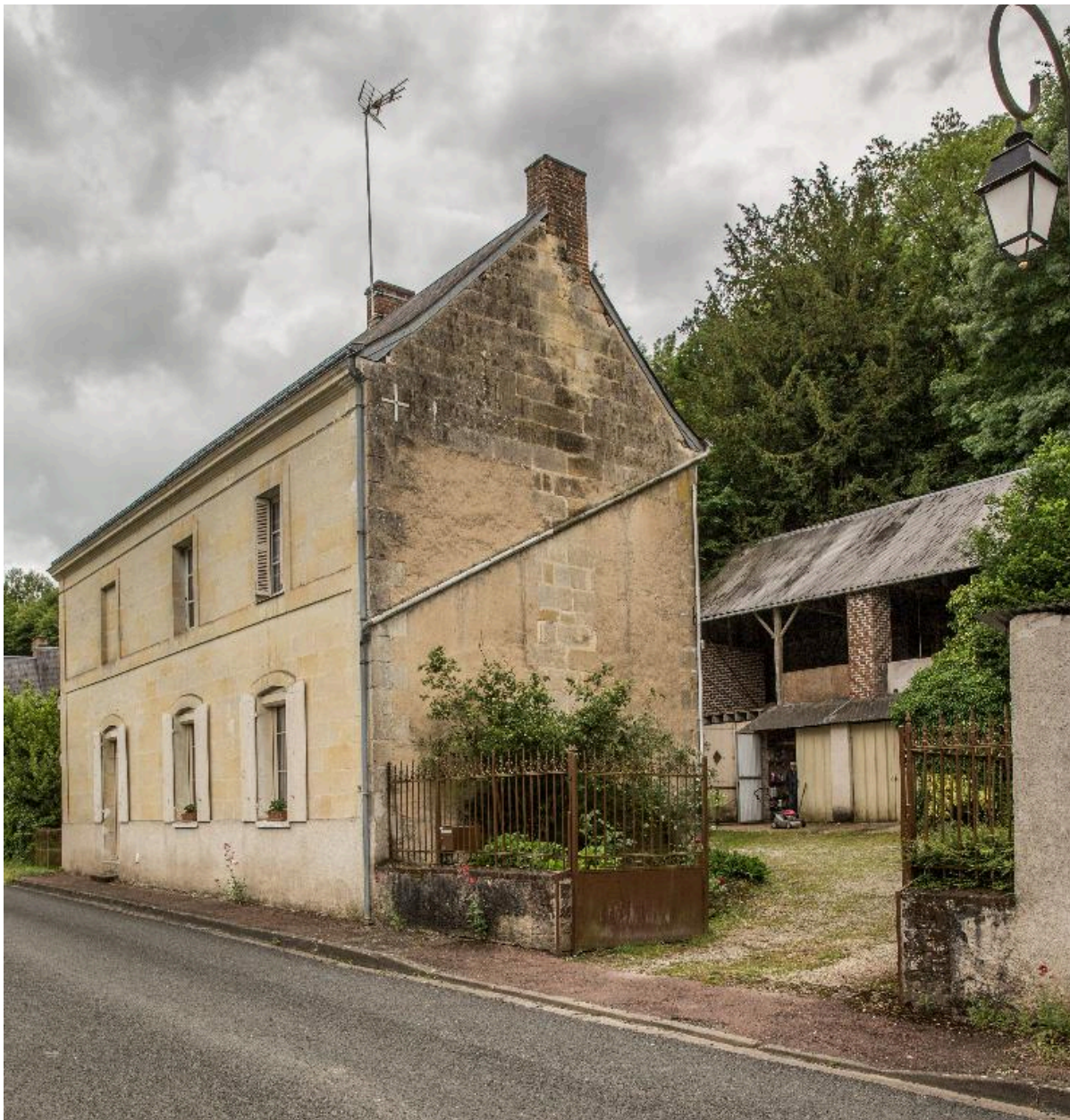
26, rue de la Vallée du Bourgneuf.
