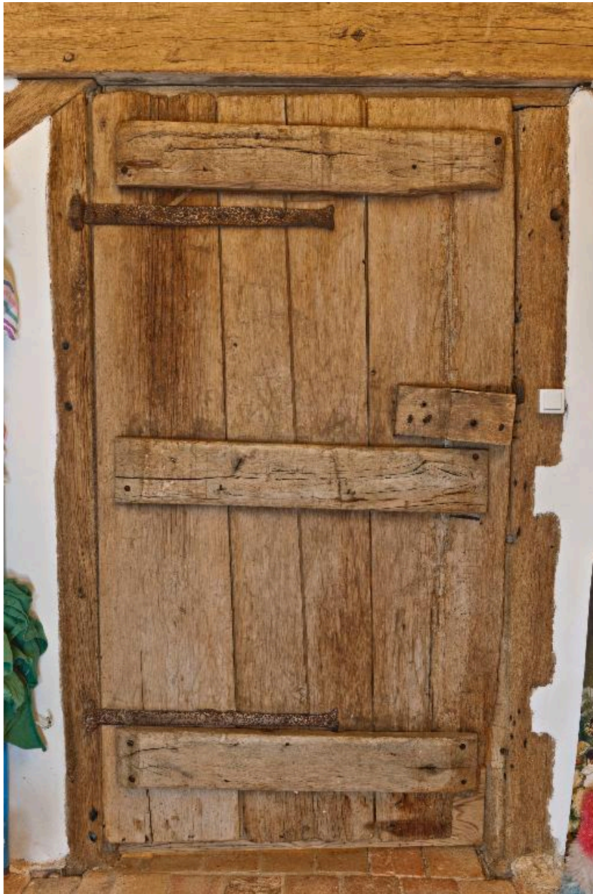
Huisserie de la porte de la pièce gauche du comble.
