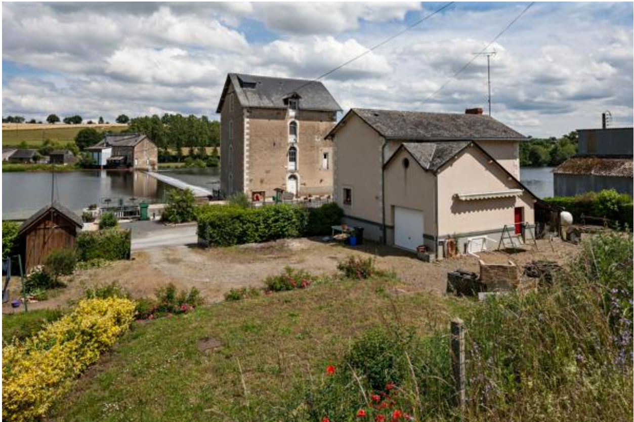
Vue d'ensemble du site depuis le nord-ouest : au premier plan, la maison éclusière et le moulin de la Petite-Bavouze ; à l'arrière-plan le moulin de la Grande-Bavouze
