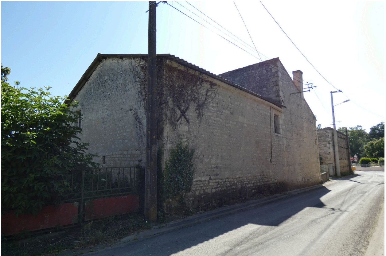
Dépendance à l'arrière du logis, vue depuis l'ouest.
