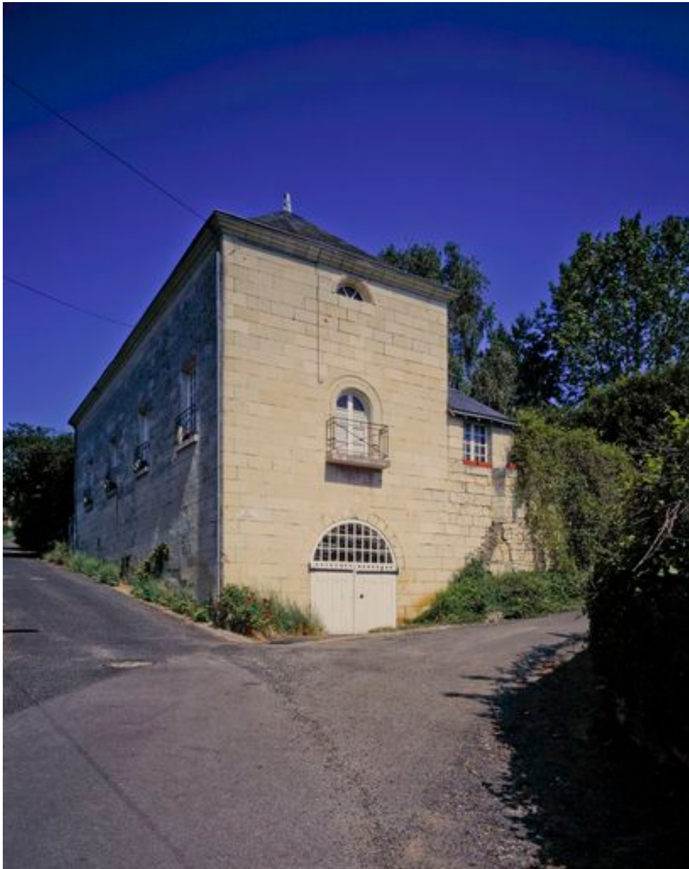
Ecart des Lizandières. 1, rue des Caffaux, maison et cave.
