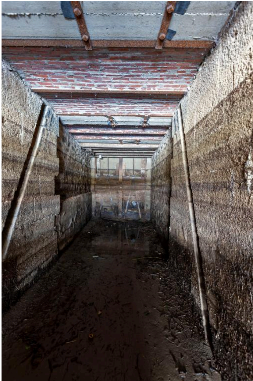
Vue intérieure du coursier, depuis l'aval, en 2019.
