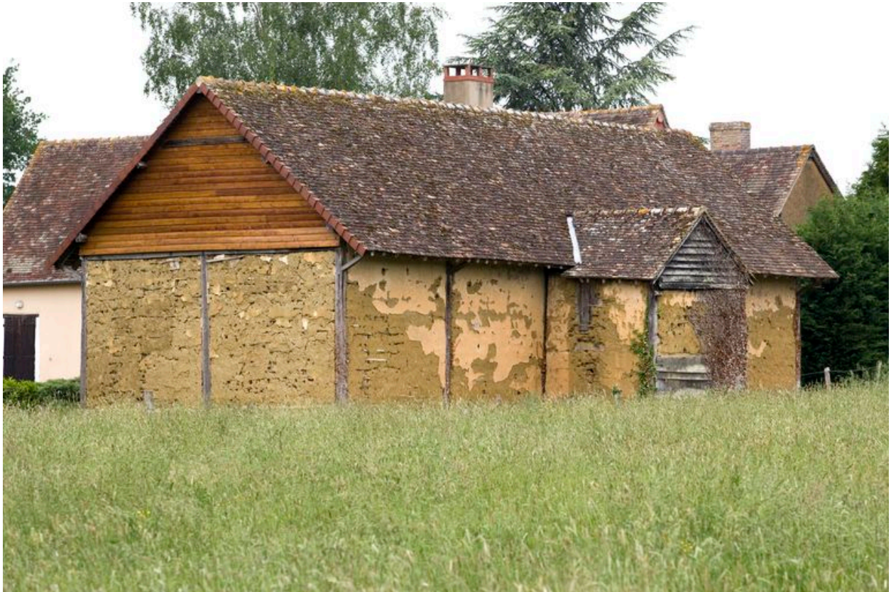
Les Bommeries : élévation postérieure de la grange.
