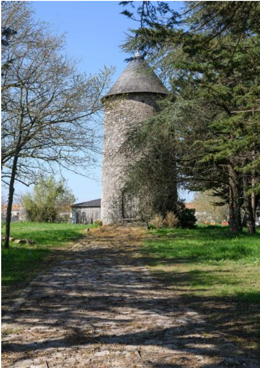
Moulin à farine dit moulin des Buttes (n° 1) ou moulin de l'Ouche-Neuve. Vue d'ensemble depuis le sud.
