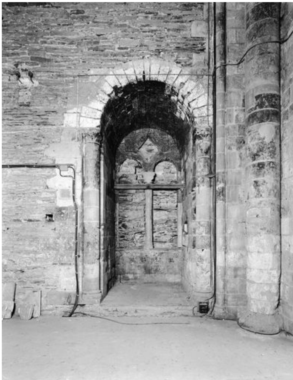
Tour-clocher dite tour Saint-Aubin, salle haute : élévation intérieure nord : détail sur la baie murée.
