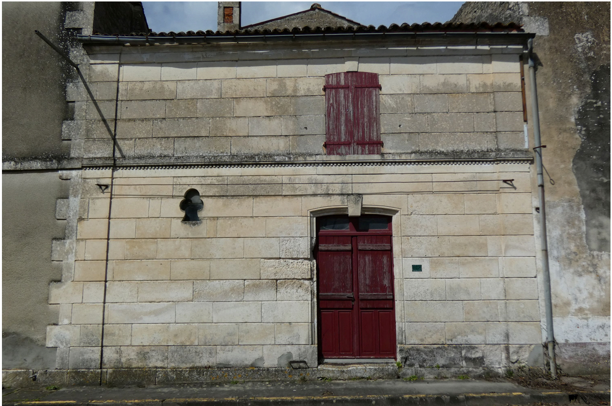
La façade, en pierre de taille, du corps de bâtiment sud-ouest.
