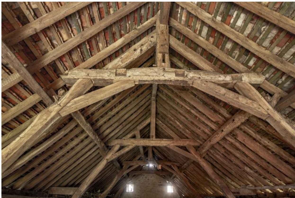
Vue de la charpente de la grange.
