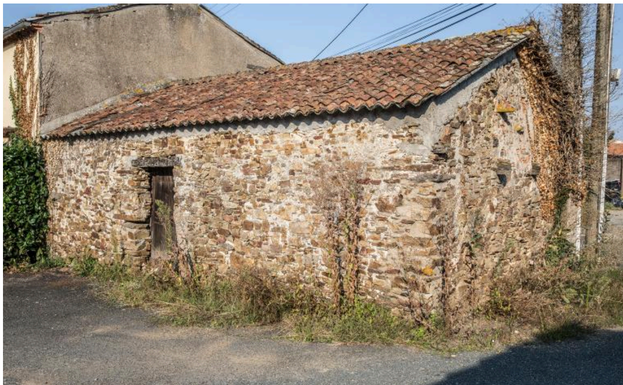
Habitation en rez-de-chaussée à une pièce sous charpente. Mur gouttereau postérieur. Le Praud, Divatte-sur-Loire. Cadastre 2018, ZV 01-267.
