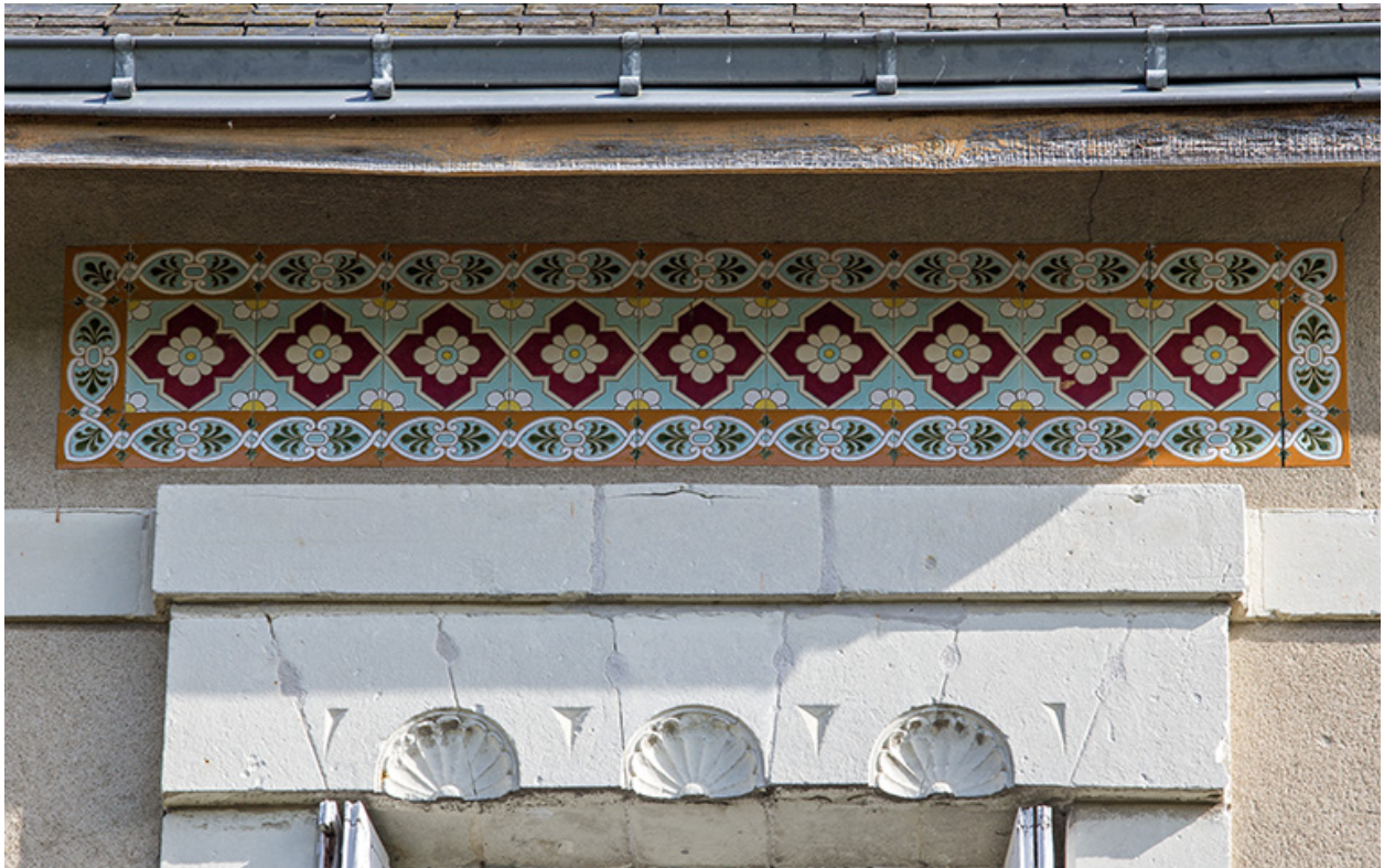
Façade côté rue, détail : décor au-dessus des travées de fenêtres.
