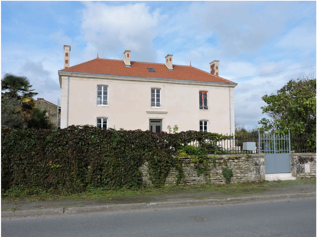
La demeure vue depuis le sud-ouest.
