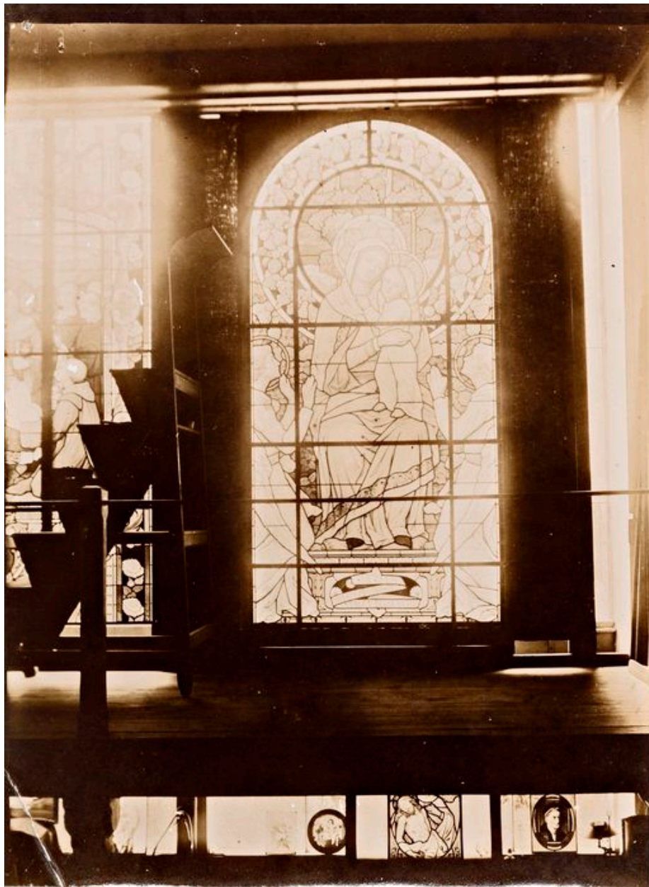
Photographie de la verrière dans l'atelier d'Auguste Alleaume, avant sa pose.
