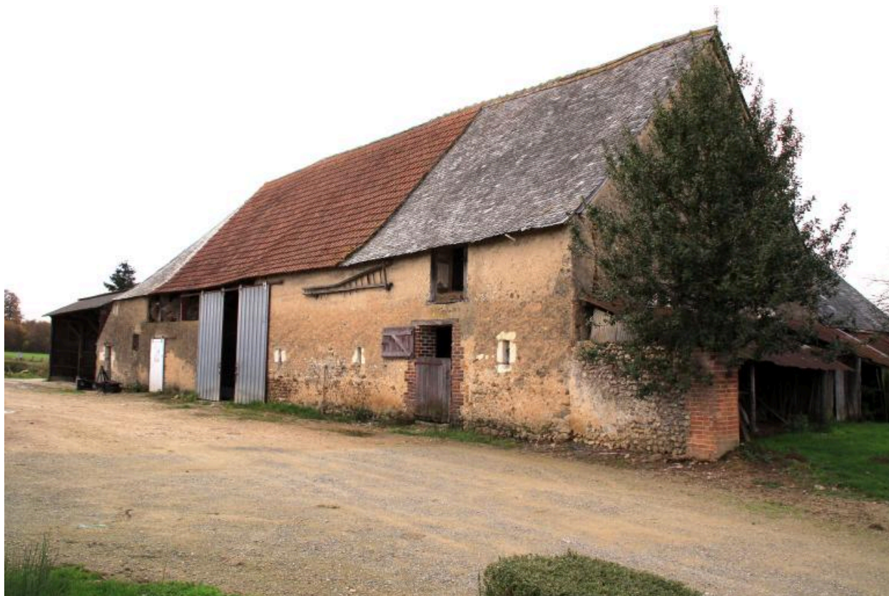
Grange-étable, façade sur cour.
