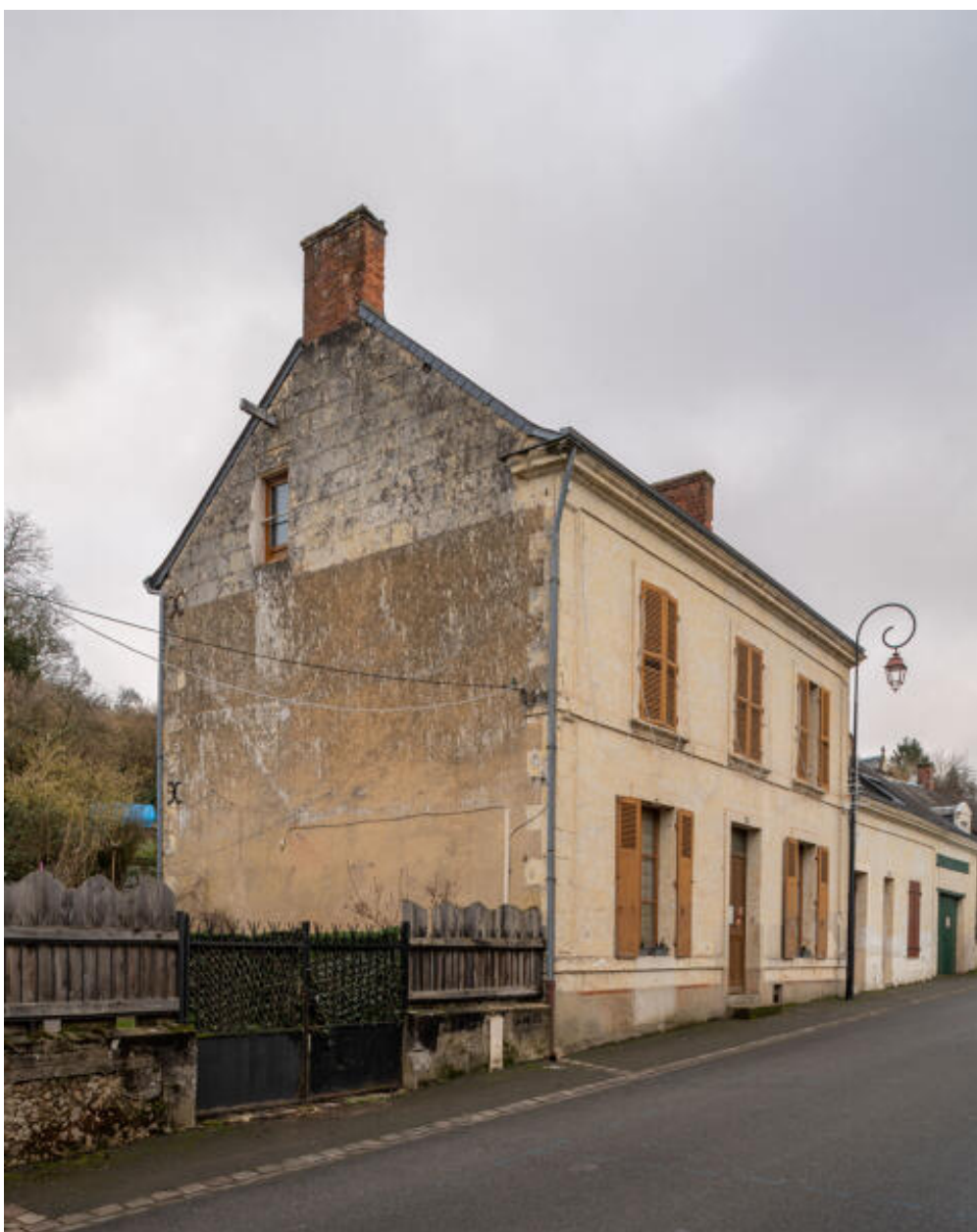
Maison avec façade en pierres de taille calcaires, 24 rue Neuve.
