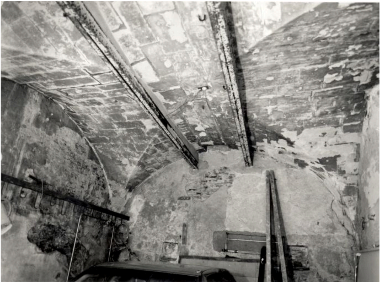
Communs, partie droite : pièce subsistante au rez-de-chaussée, mur gauche et postérieur.
