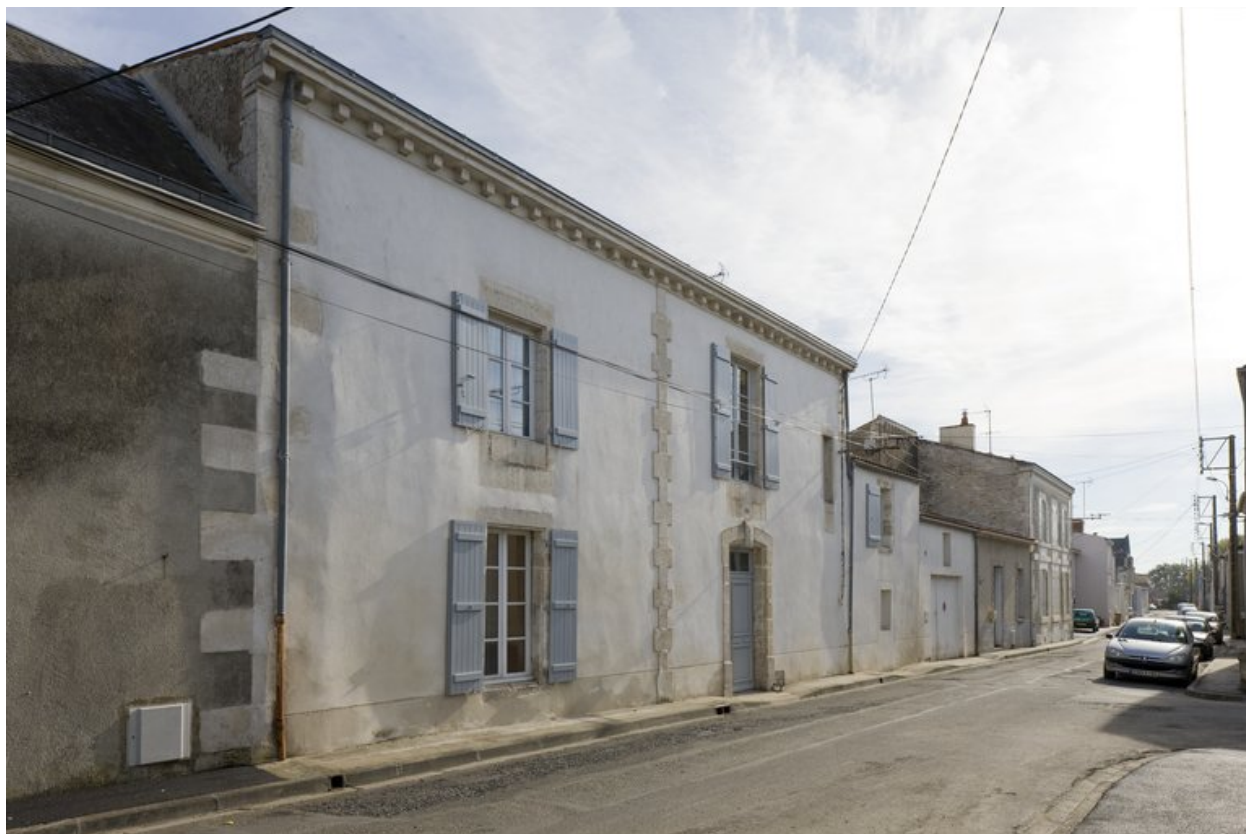
Façade ouest sur rue.
