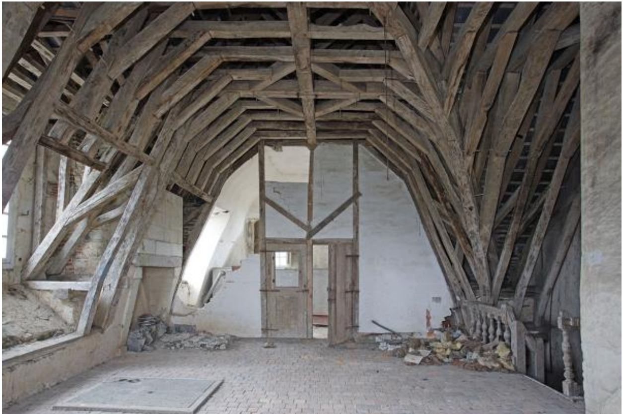
Le grand comble et sa charpente, croupe du pavillon nord.
