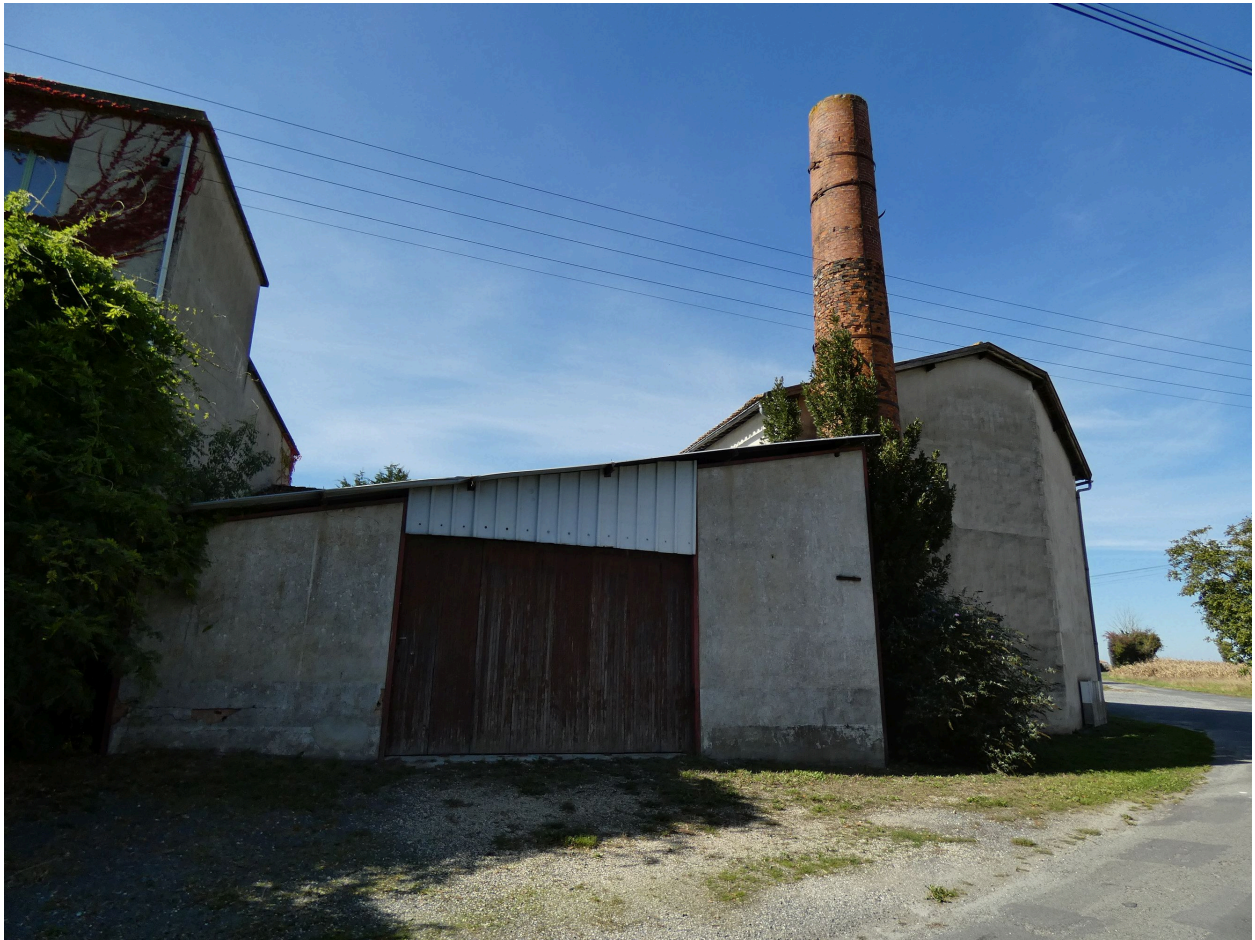
La chaufferie vue depuis l'est.
