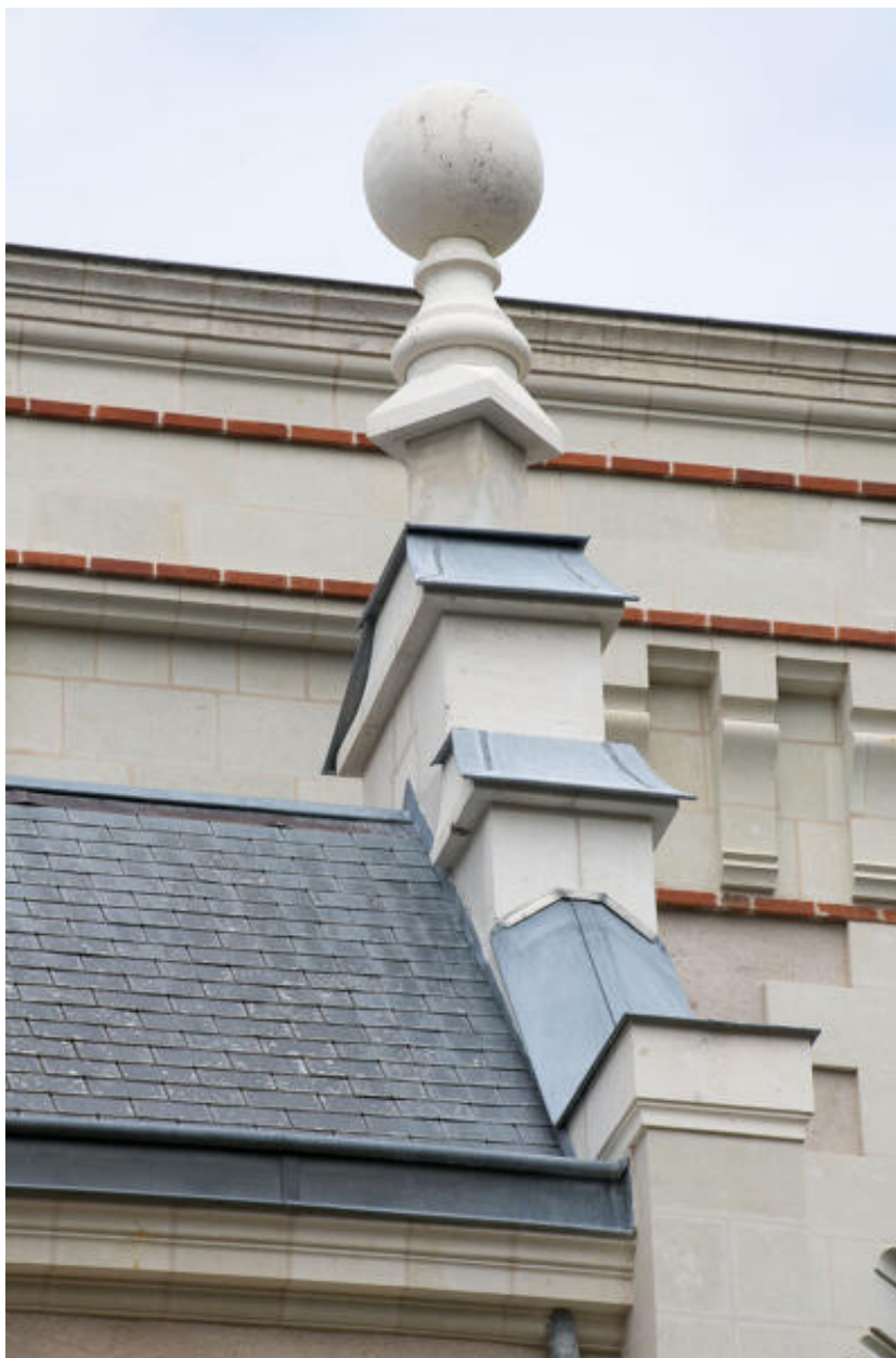
Façade sud. Détail d'un amortissement.
