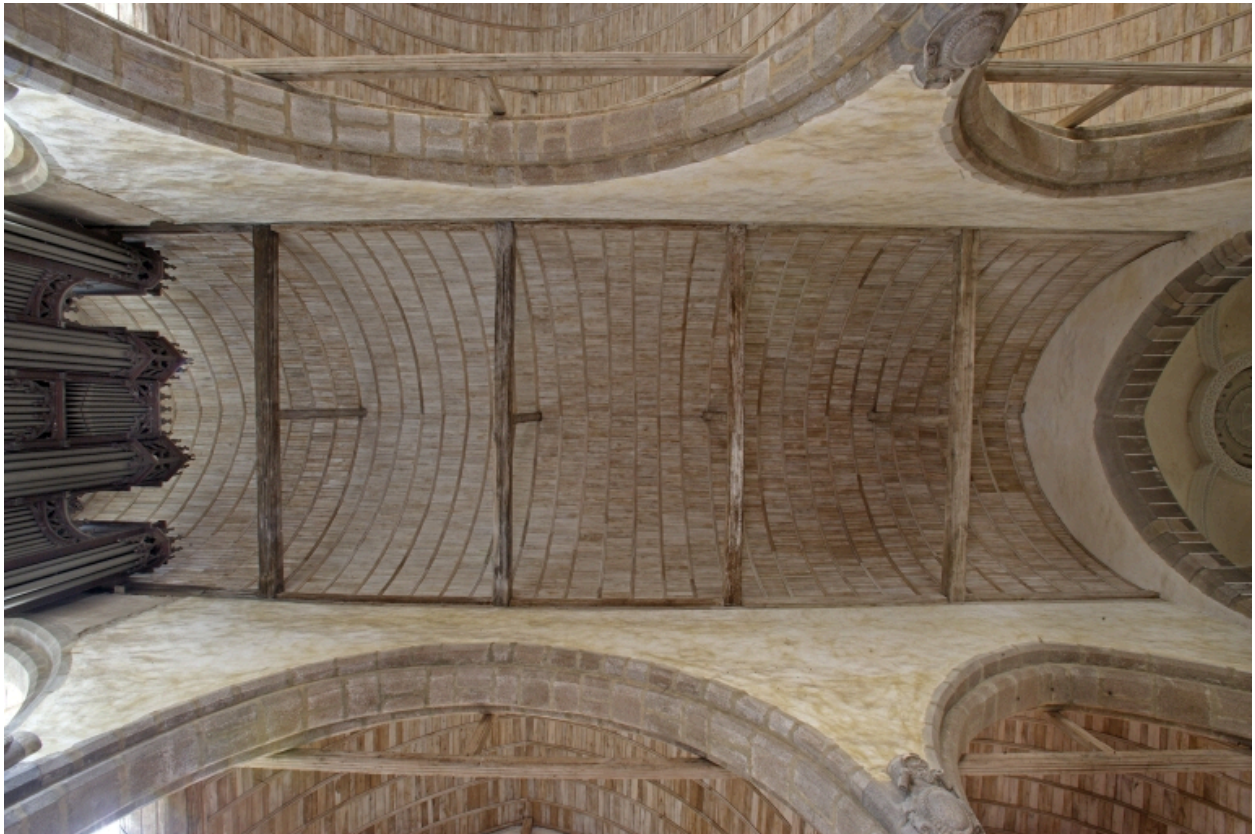
Nef, voûte restaurée : vue géométrale.
