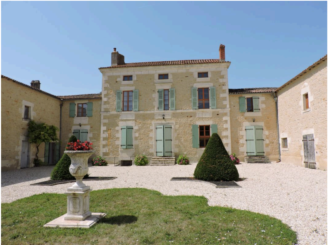
Le logis vu depuis le nord-est, côté cour.
