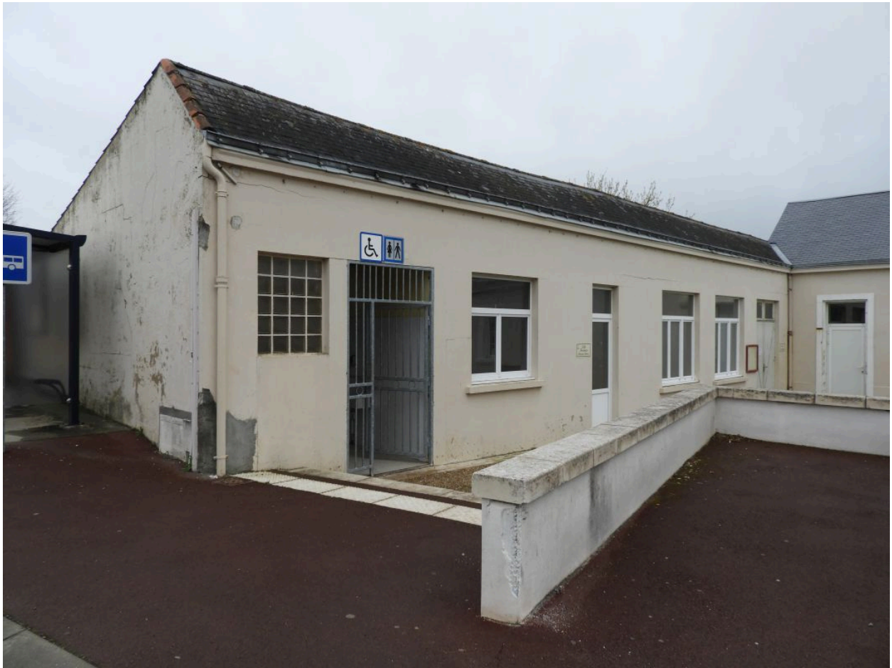
L'aile en retour d'équerre à l'ouest, abritant la salle de musique, vue depuis le sud.
