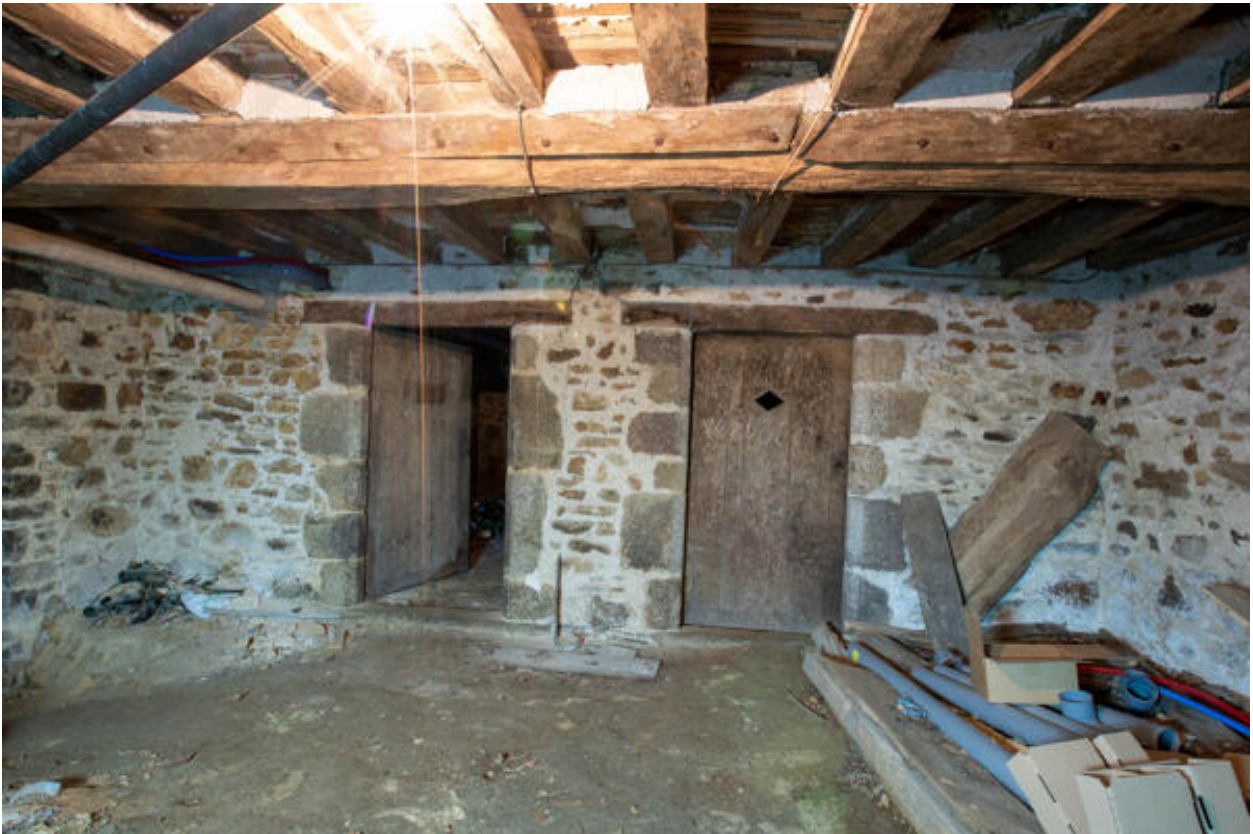
Le sous-sol du corps central.
