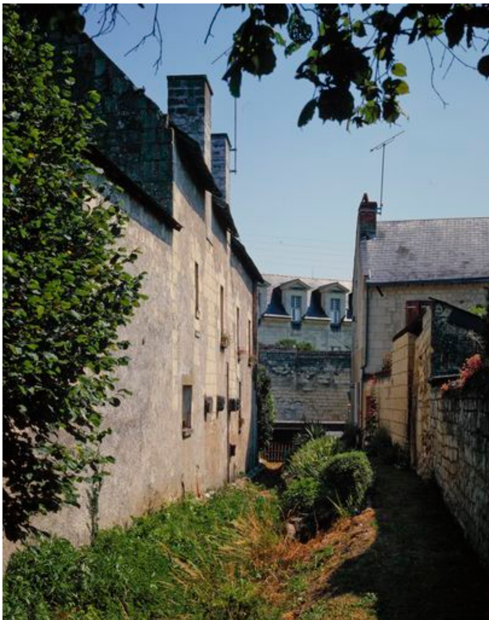
Façade sud, donnant sur le ruisseau de la Vacherie (en 1994).
