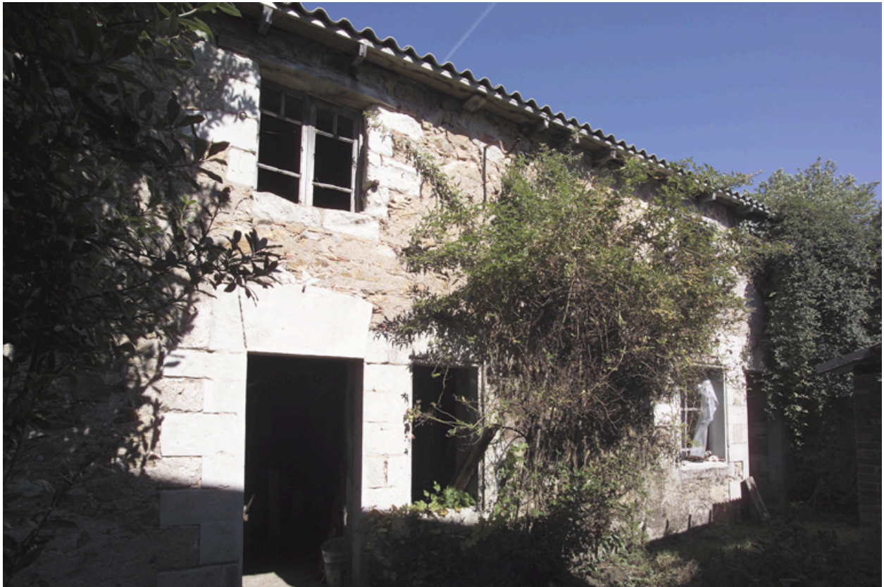
Vue de la façade sud.
