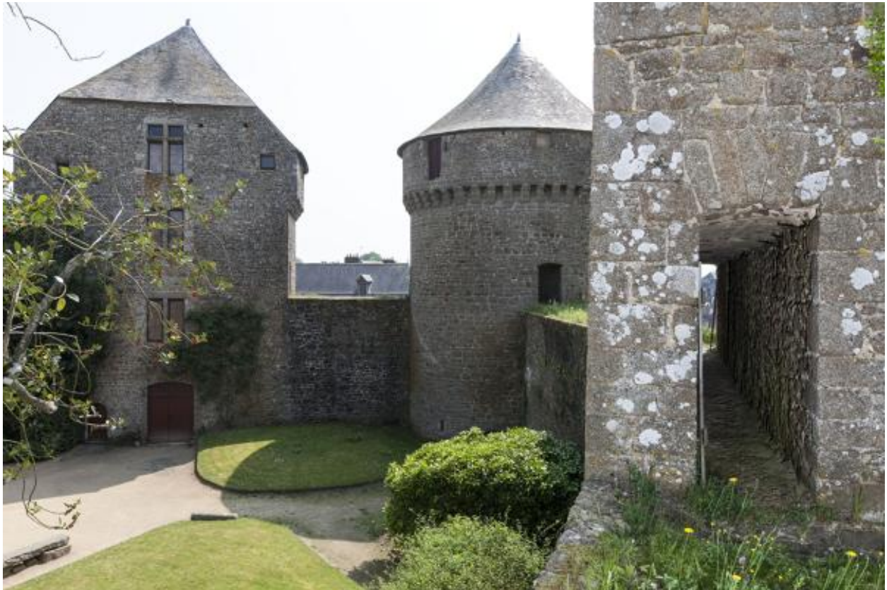
Tour 3, 4 et passage du chemin de ronde dans la gorge de la tour 5.
