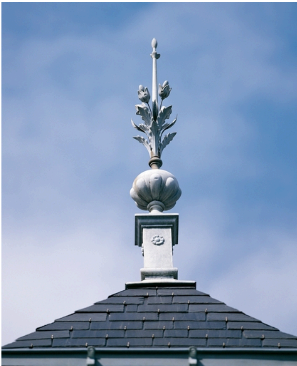
Détail de l'épi de faîtage en zinc de l'hôtel Flepen;
