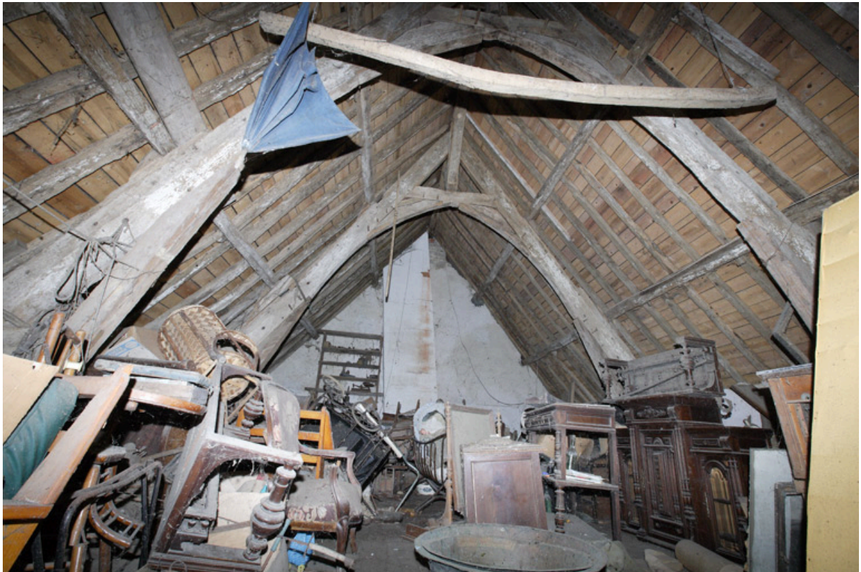
Logis. Charpente. Vue d'ensemble.
