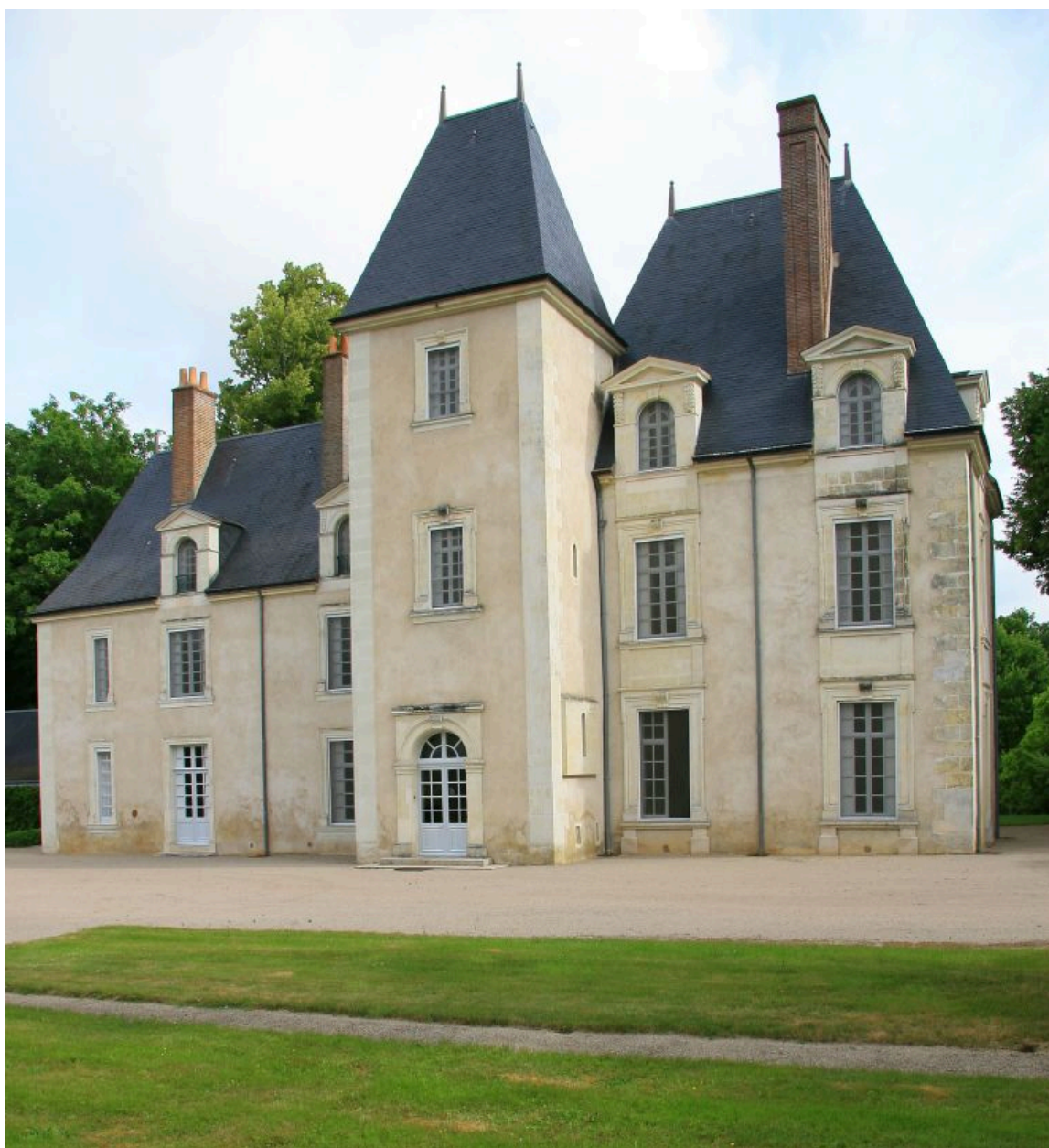
Château : élévation sud, depuis le sud-est.
