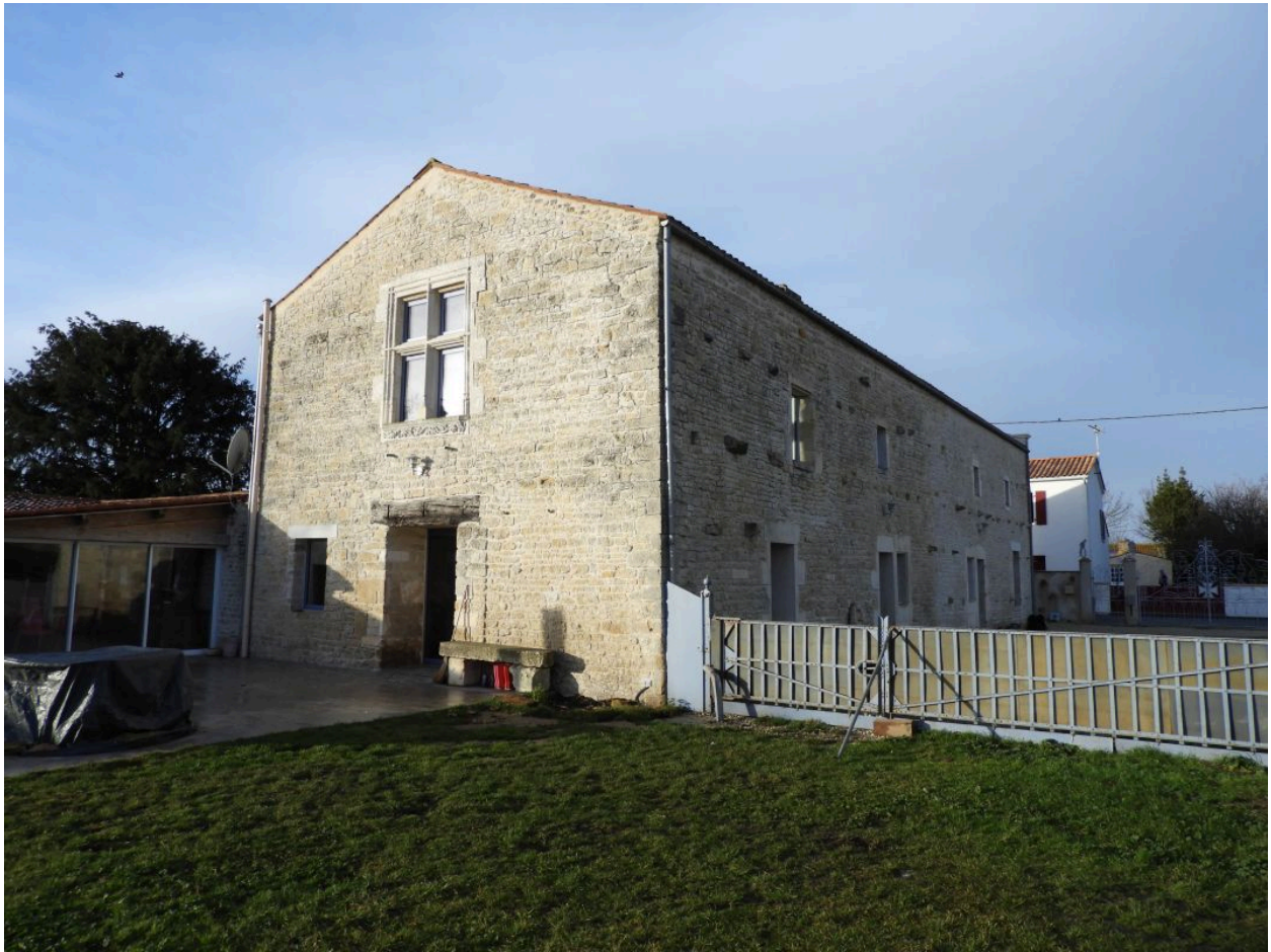
L'ancienne grange monastique vue depuis le nord-est.
