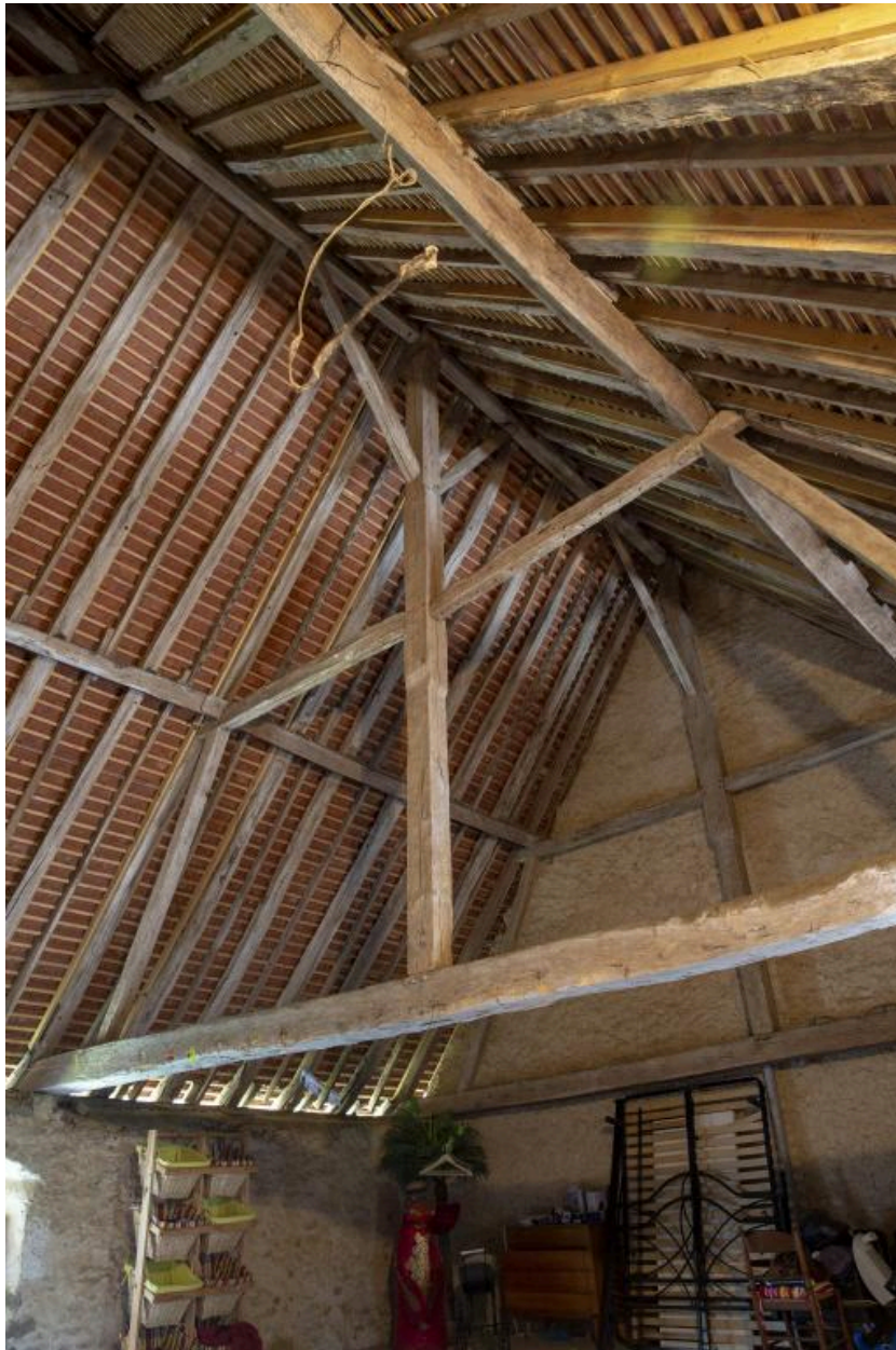
La charpente sur la partie basse du manoir.
