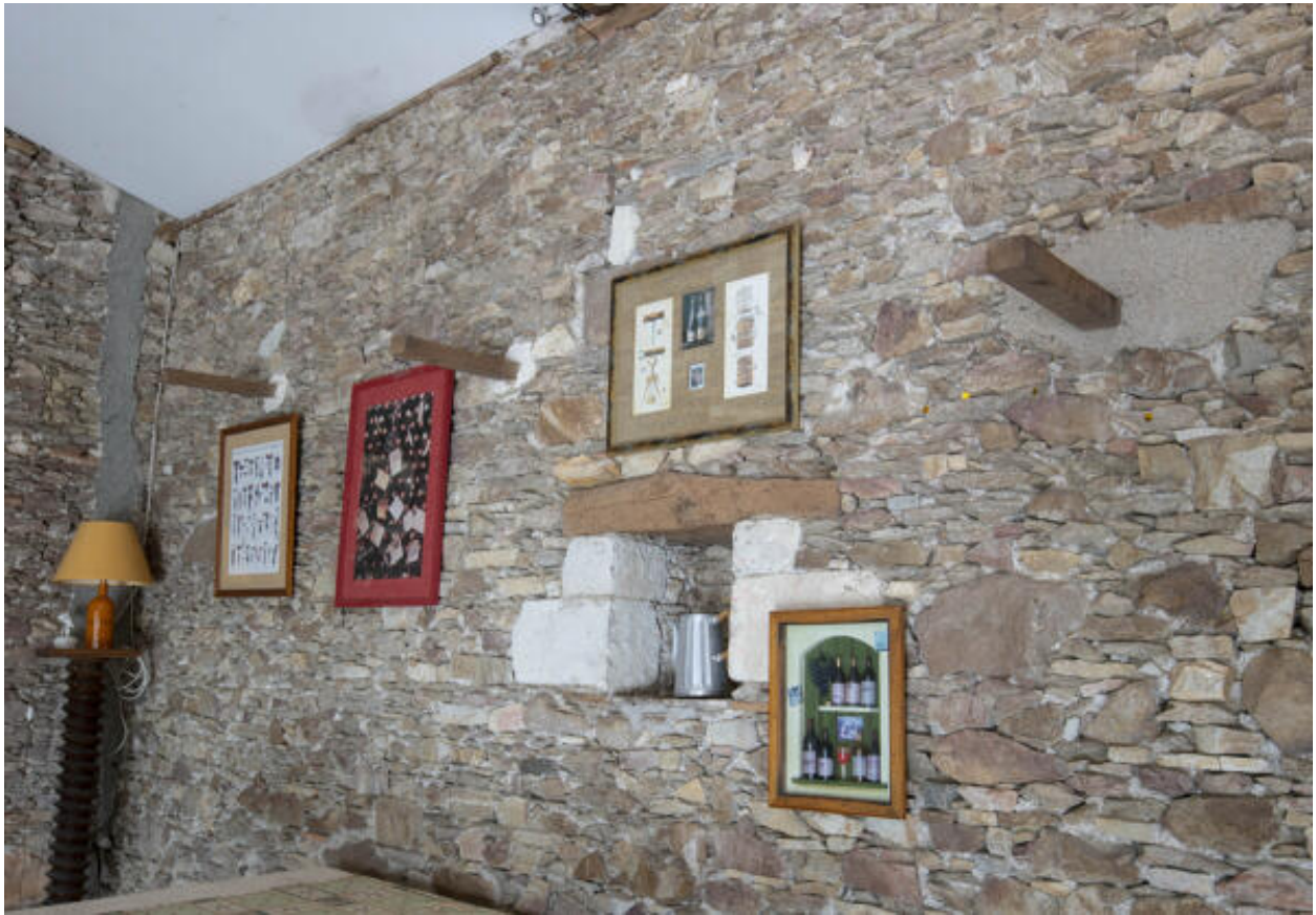
Détail d'une baie condamnée.
