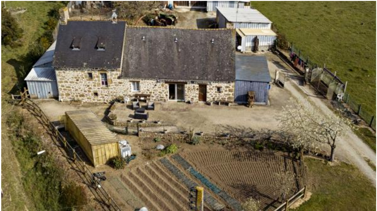
Ferme de la Monnerie.
