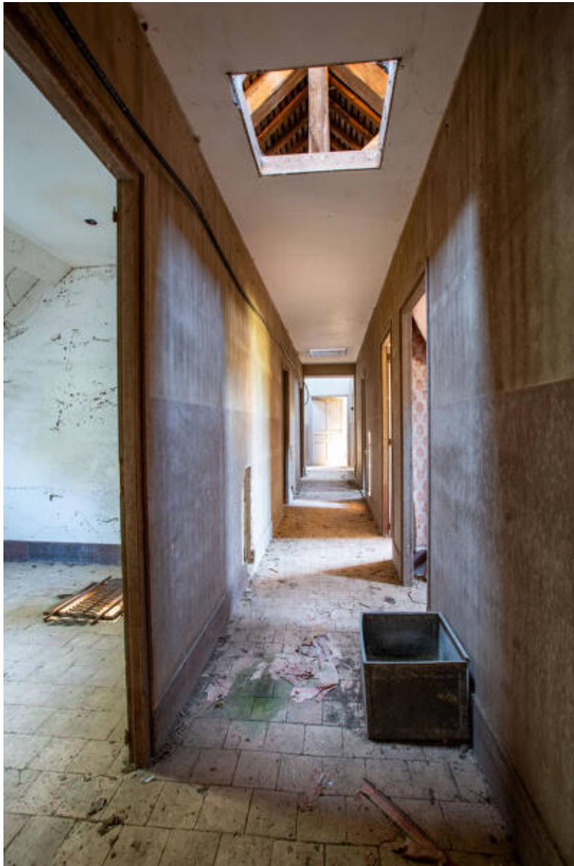
Le couloir des chambres des garçons d'écurie.
