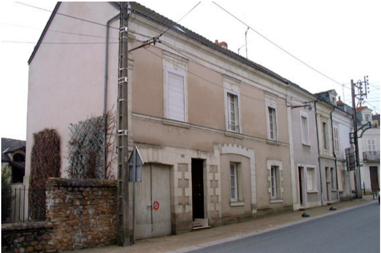
Maison à étage carré : ouvertures du rez-de-chaussée remaniées.
