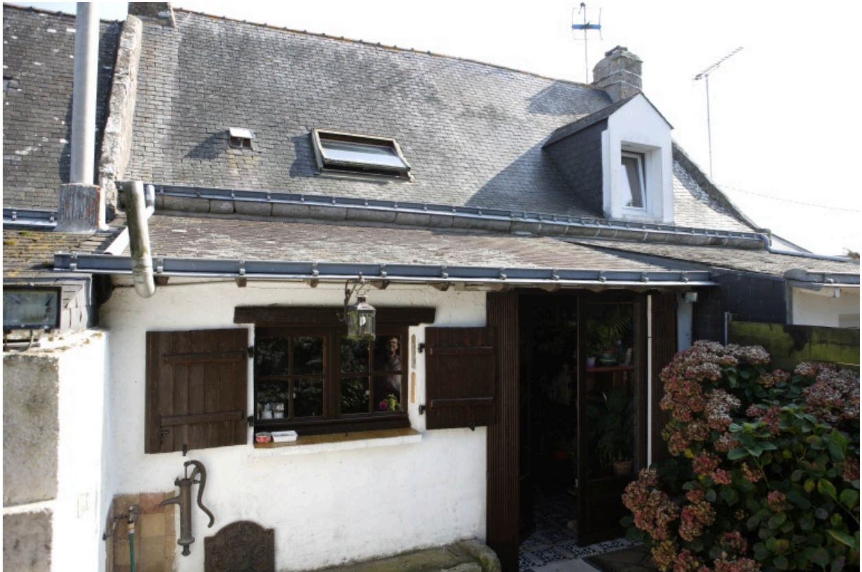
Vue de la façade arrière du n° 7 rue Folie.
