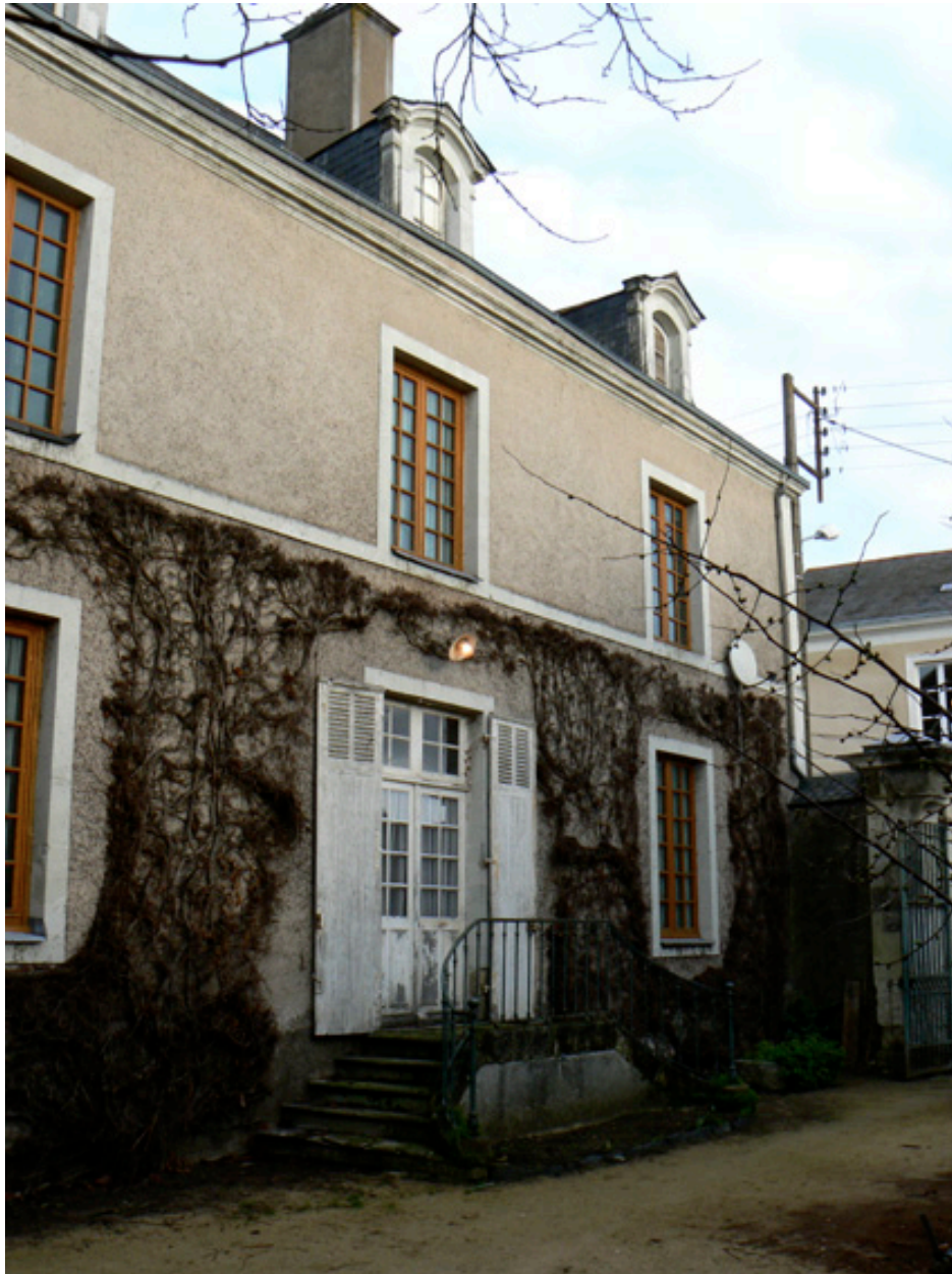
Façade principale sur cour.
