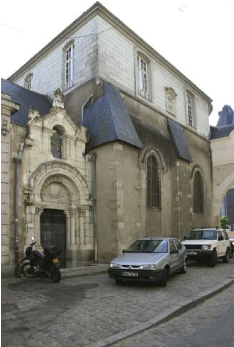
Chapelle Saint-Eloi. Elévation extérieure sud, avant restauration.
