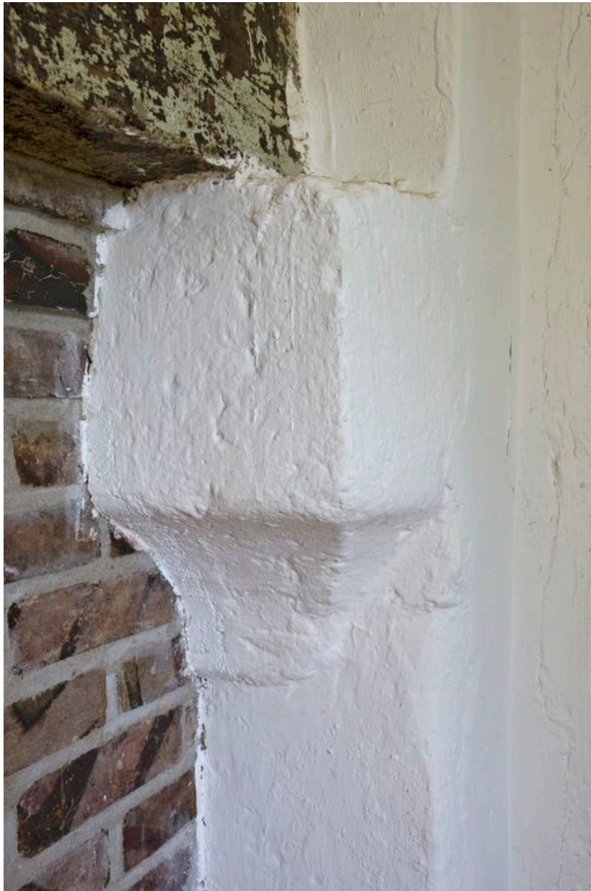
Corbeau droit de la cheminée.
