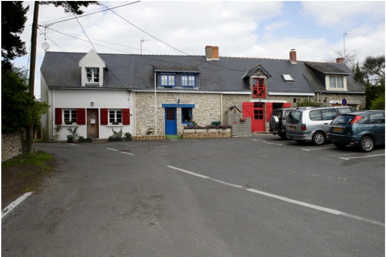
Vue d'ensemble de la rangée.
