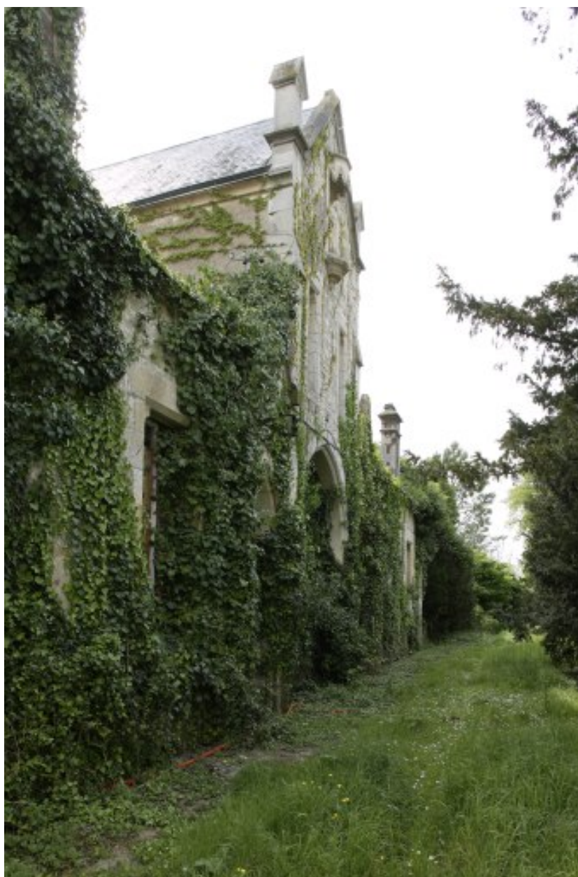
Pavillon d'entrée (vue prise de l'est de la première cour).
