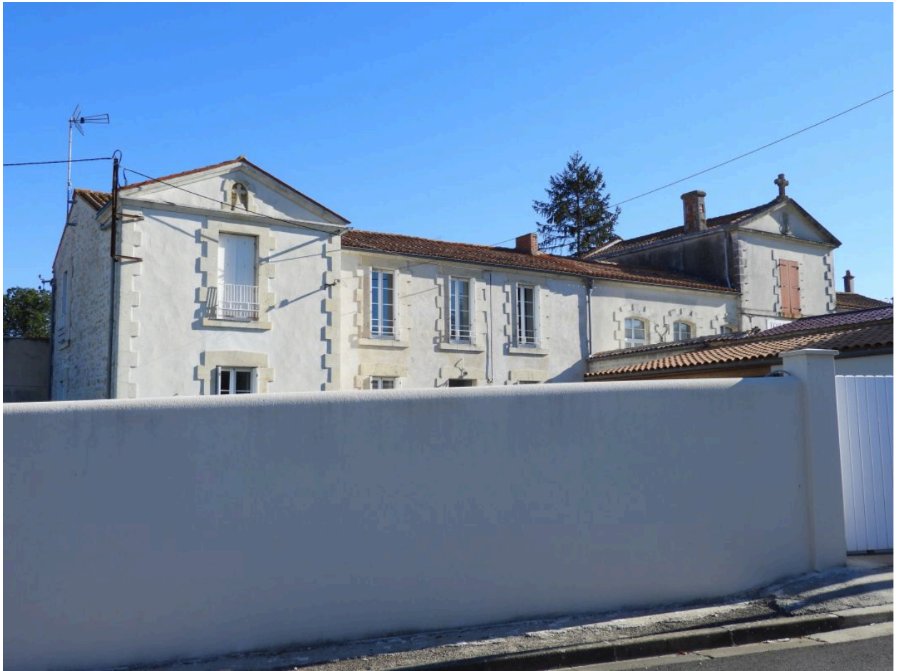
L'aile ouest vue depuis le sud-ouest.
