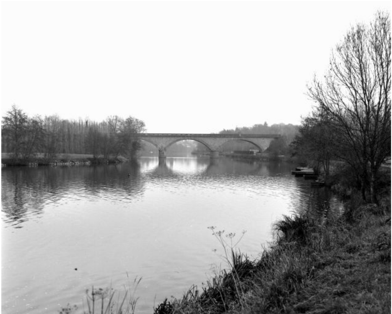
Vue depuis la rive droite en amont.
