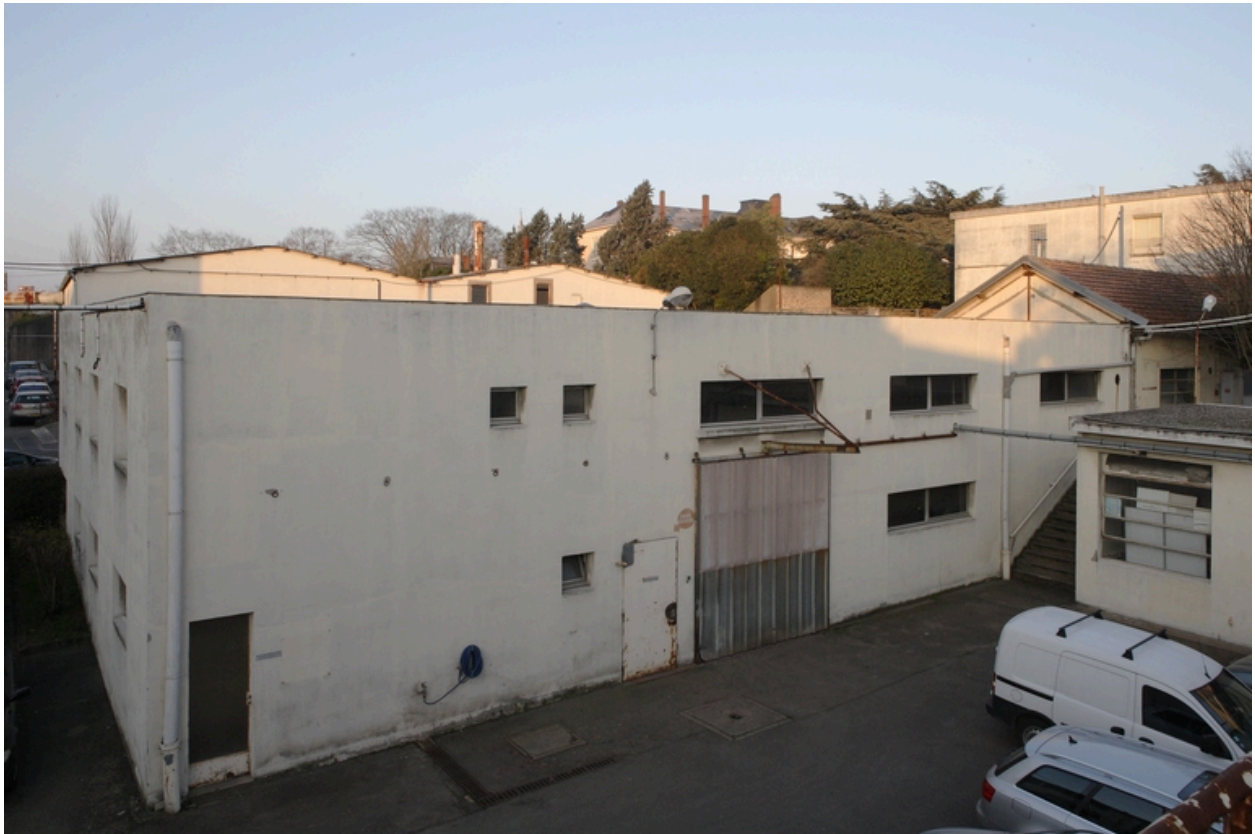
Atelier de réparation 1, construit en 1951.
