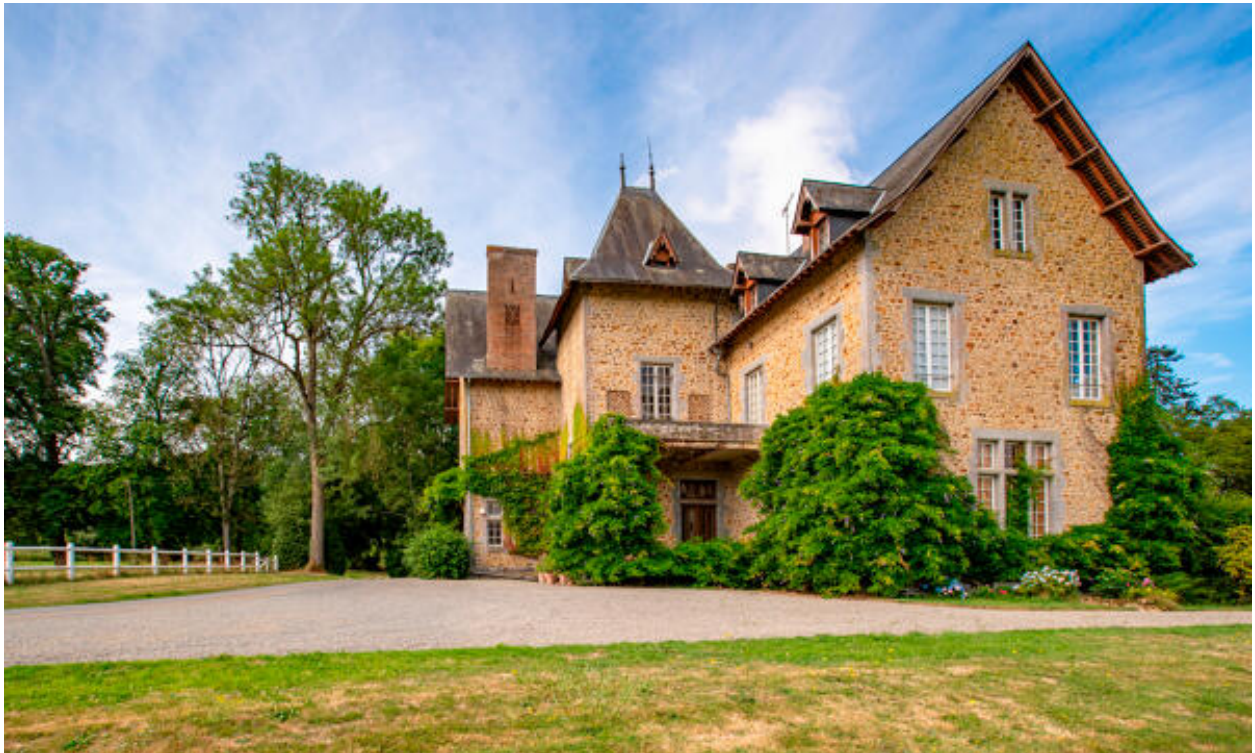
L'élévation vers le parc et l'entrée de la propriété.
