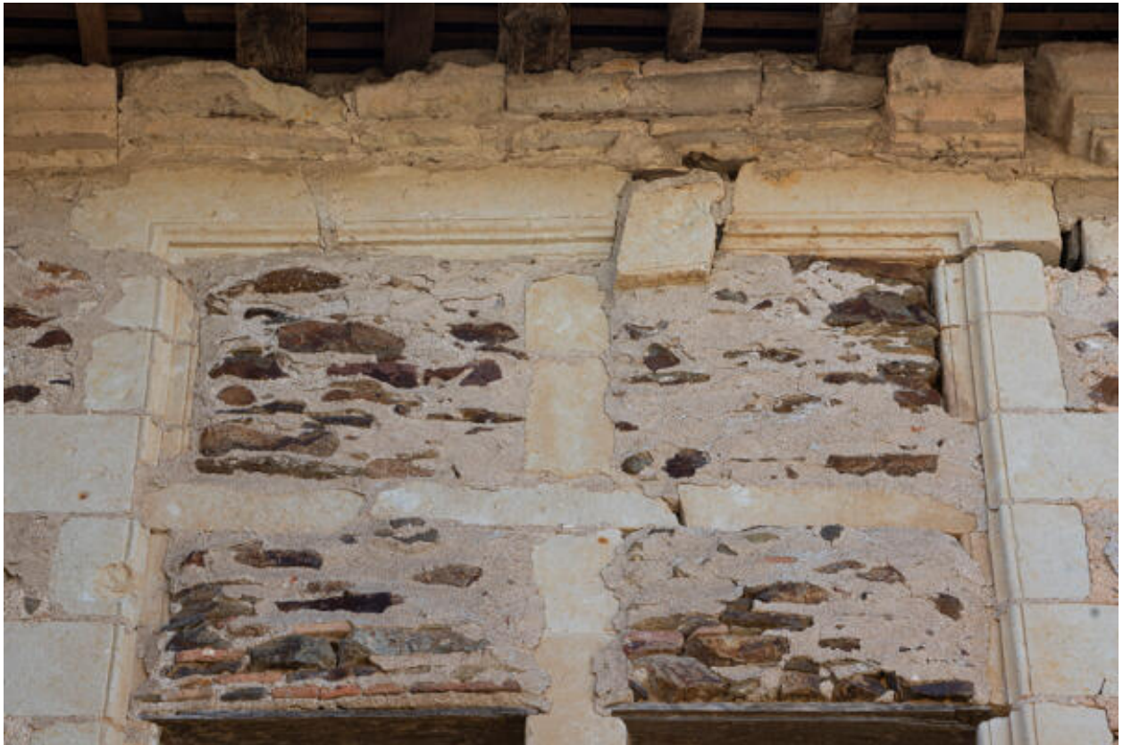
Une fenêtre murée de la façade postérieure.
