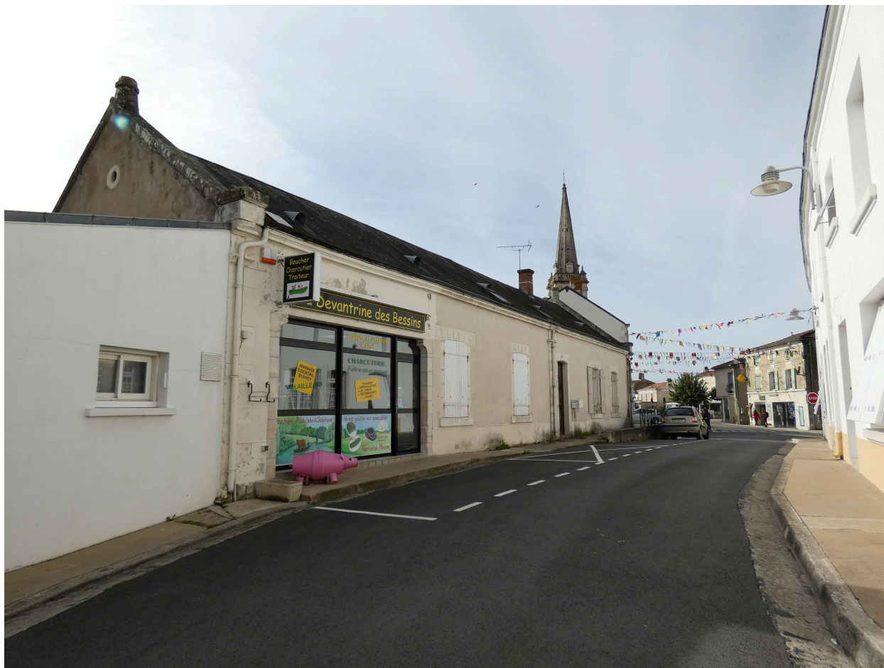
Le bâtiment vu depuis le nord.
